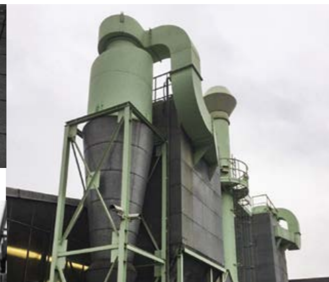
Installation einer modernen Luftfilteranlage in Andernach
