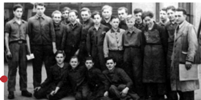
Wiederaufbau der Formgießerei
